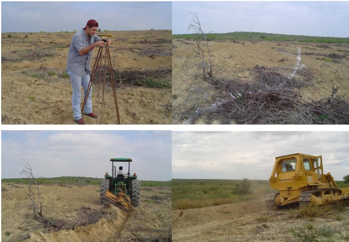
Figura 1. Trazo y construcción de curvas a nivel.
