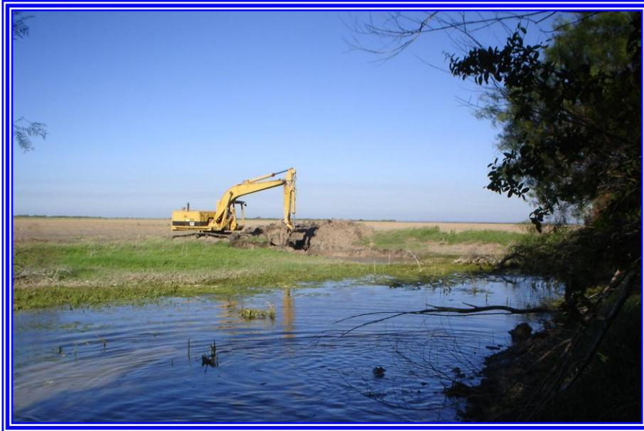
**Figura 7. Levantamiento de bordos de la presa del Ejido La Azufrosa, Municipio de Reynosa, Tamaulipas.**
