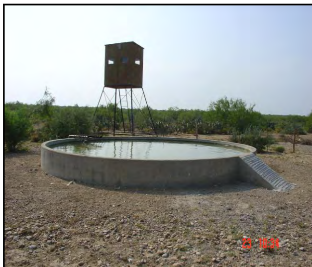
Después de la rehabilitación
