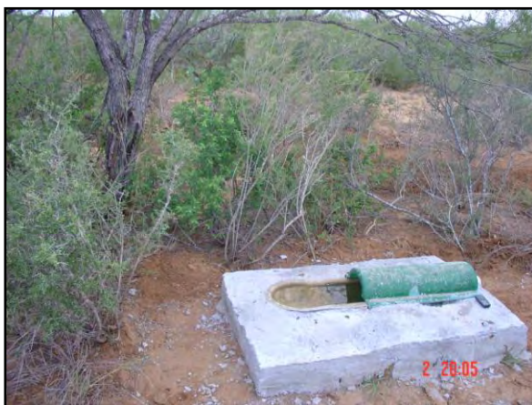
Bebedero ya instalado
