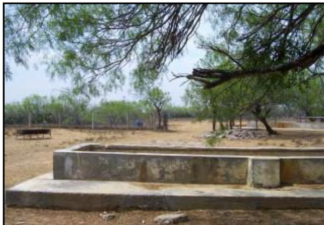
Después de la rehabilitación
