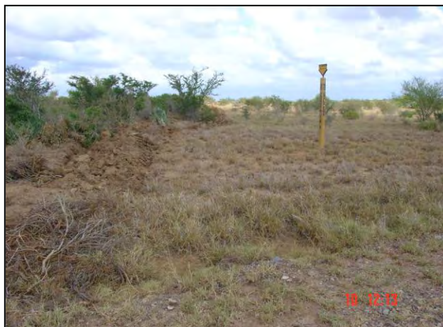
Después de la construcción en 50 hectáreas
