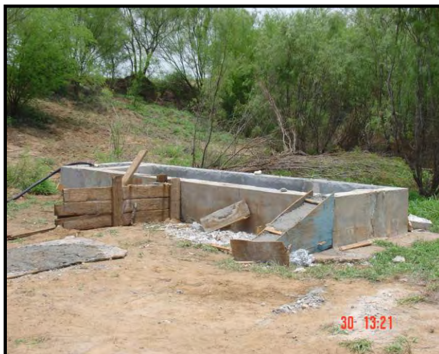
Después de la rehabilitación
