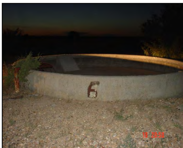
Después de la rehabilitación
