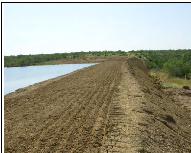
Después de la rehabilitación
