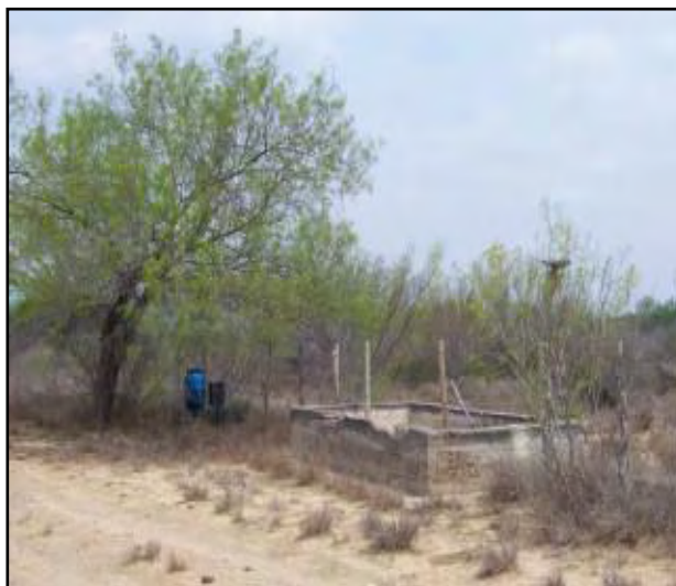
Después de la rehabilitación
