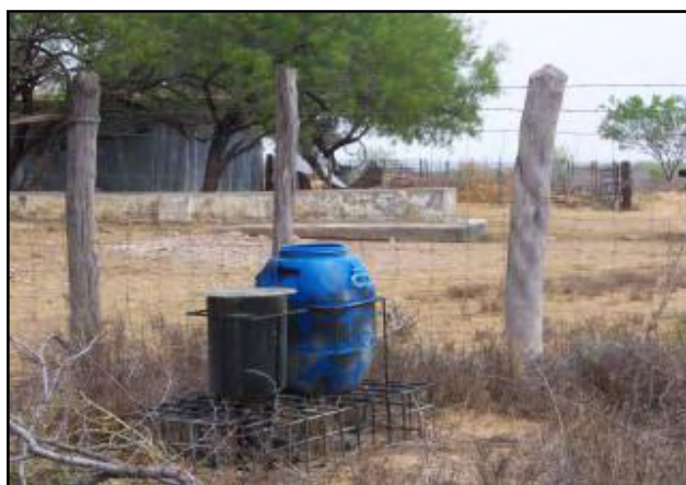
Después de la rehabilitación
