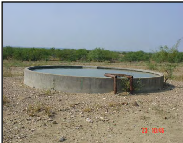
Después de la rehabilitación
