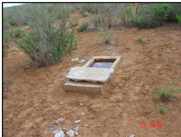
Después de la rehabilitación
