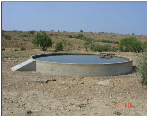
Después de la rehabilitación
