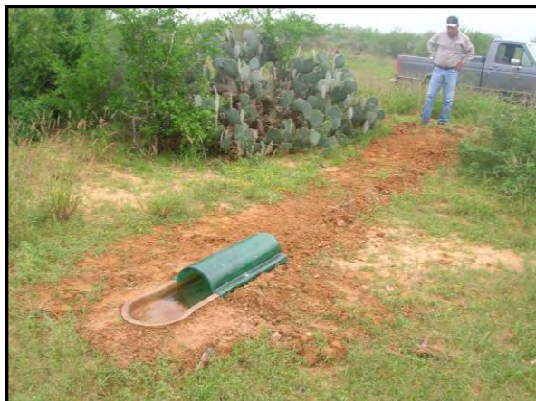
Bebedero ya instalado
