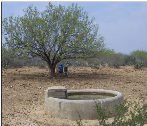
Después de la rehabilitación
