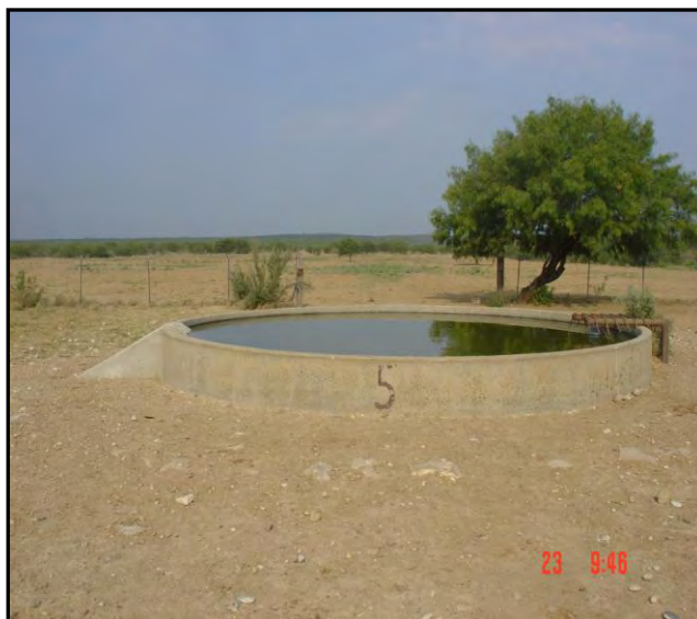
Después de la rehabilitación
