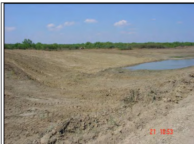
Después de la rehabilitación
