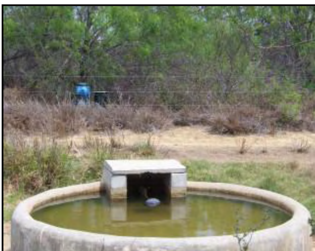
Después de la rehabilitación
