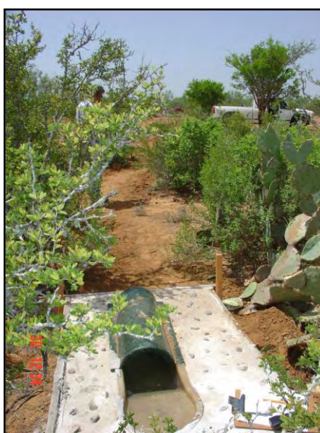
Después de la rehabilitación
