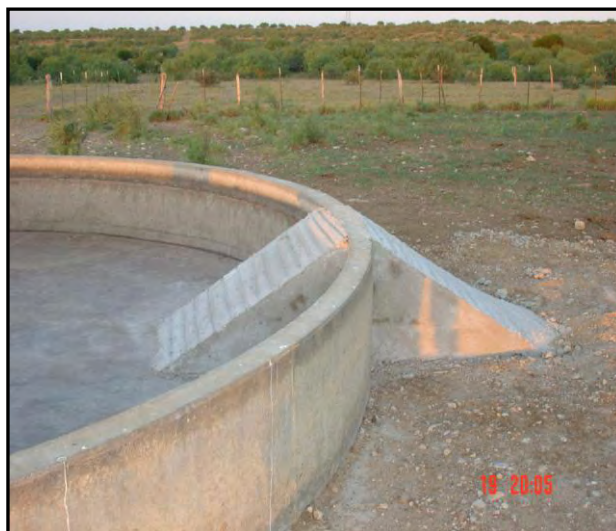
Después de la rehabilitación
