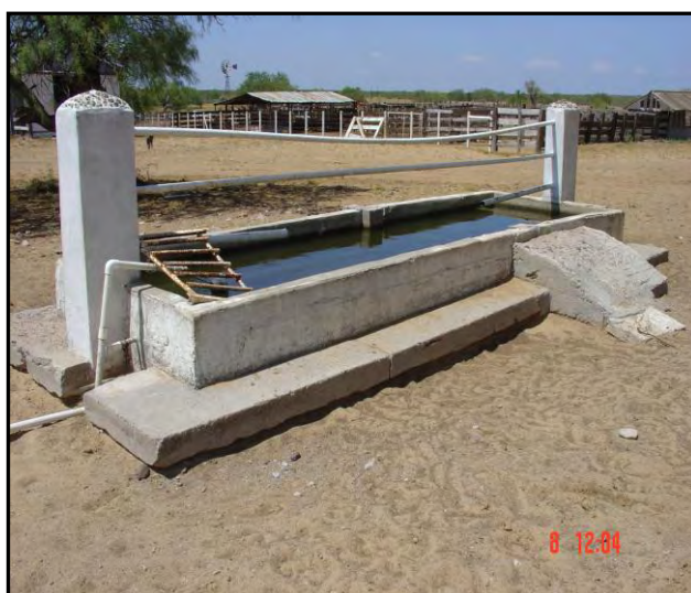
Después de la rehabilitación
