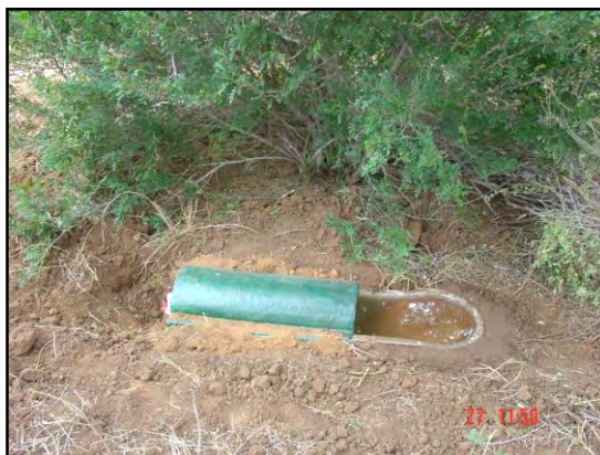
Después de la rehabilitación
