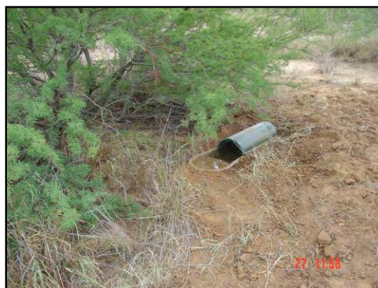
Después de la rehabilitación
