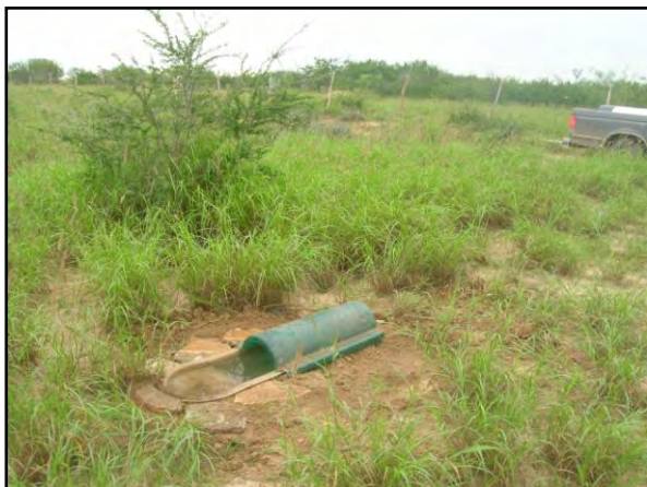
Bebedero 1 después de la rehabilitación
