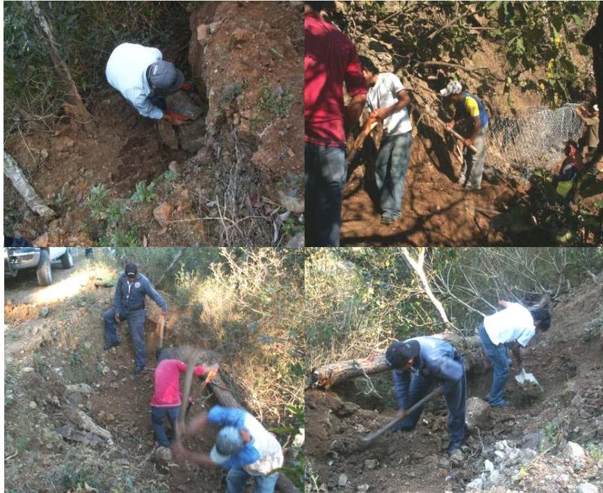
**Figura III.9** Acondicionamiento del sitio a construir el gavión mediante actividades mecánicas
