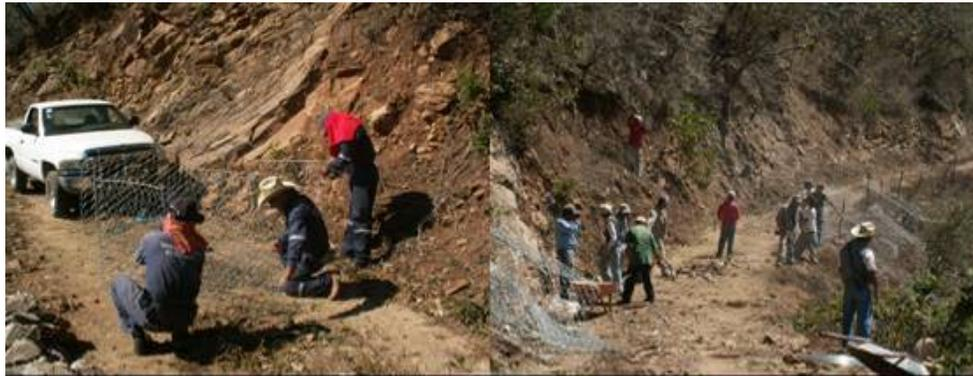
Figura III.11 Armado y montaje de estructuras: gaviones
