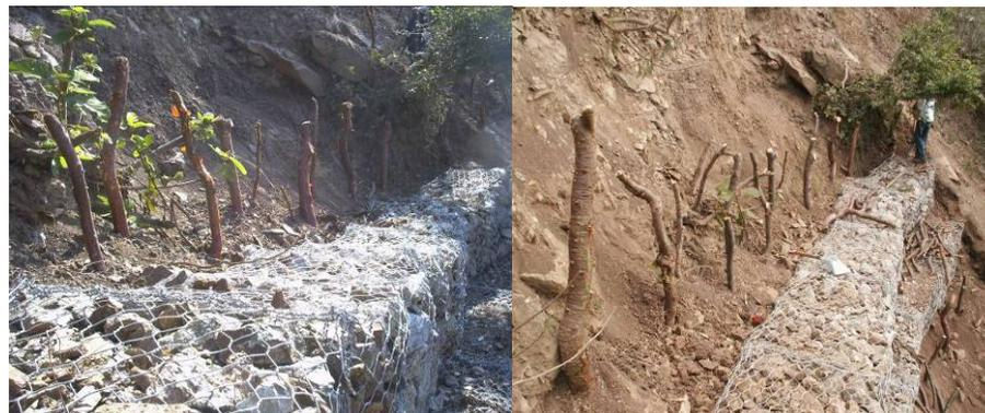
**Figura III.10** Presas filtrantes de gaviones y barreras vivas
