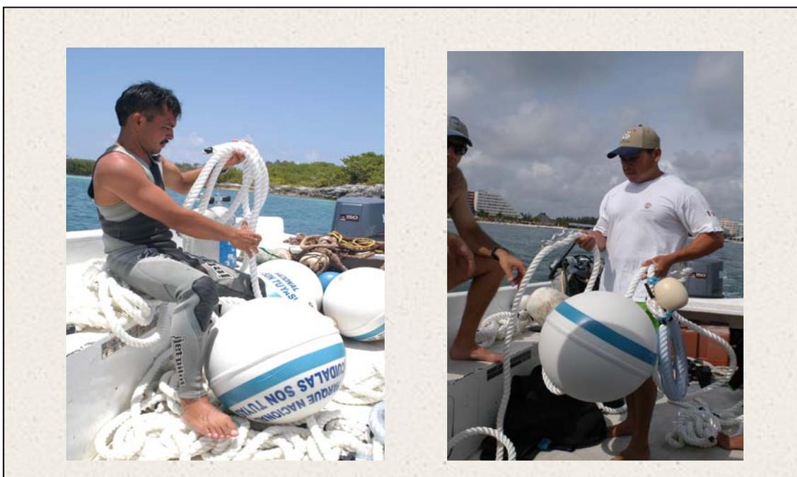
FIGURA 12. Maniobras de aseguramiento de las boyas de superficie para la instalación definitiva del SSBZR en diversas ANP de Quintana Roo.
