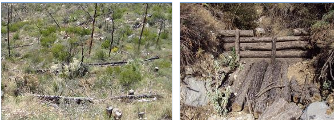
Figura 20. Utilización de material quemado como material para la protección del suelo y control de escurrimientos.
