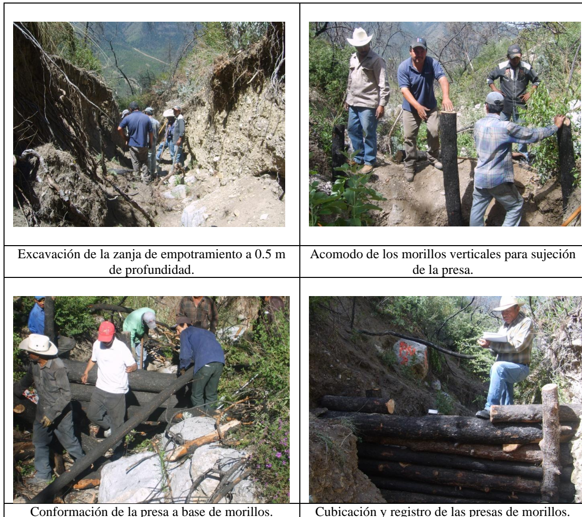
Figura 26. Construcción de las presas de morillos.
