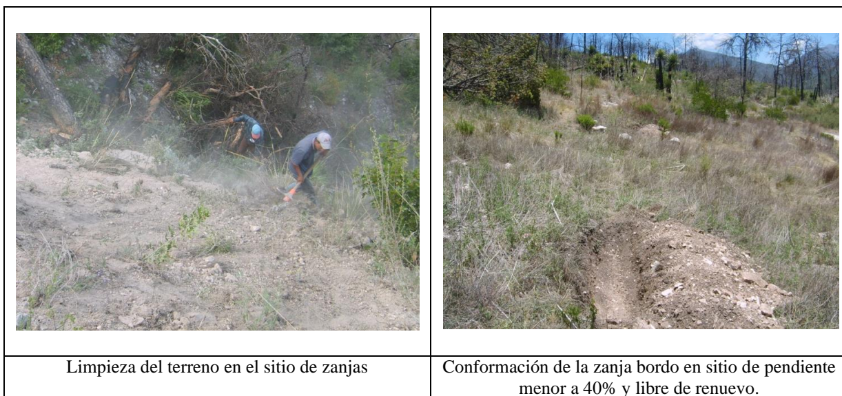
Figura 35 Construcción del sistema Zanja-trinchera
