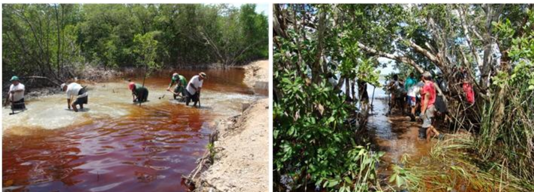
Figura 12. Trabajos de apertura y desazolve de canales en el tramo el Remate – Isla Arena, Campeche.
