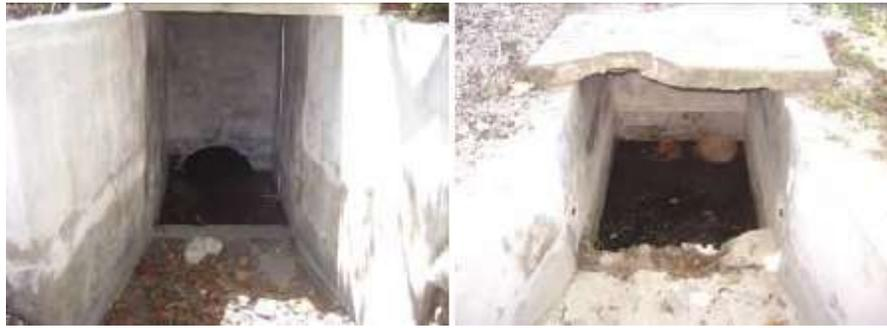
**Figura 17. Descargas 4 (izquierda) y 5 (derecha) de aguas residuales.**
