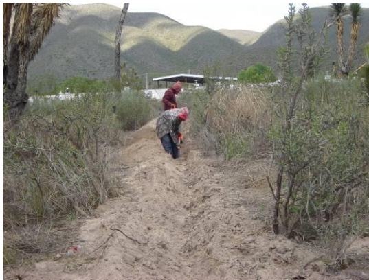
Foto 10. Conformación a mano del canal y bordo
