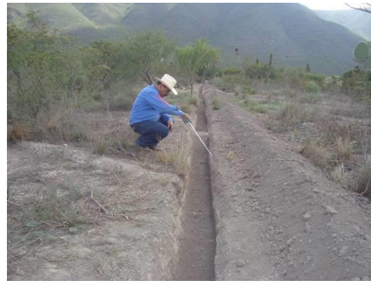
Foto 11. Canal y bordo concluido y estabilizado con composta y pasto.
