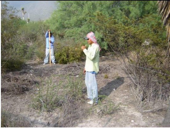
Foto 8. Trazo con nivel de manguera para los bordos y canales.
