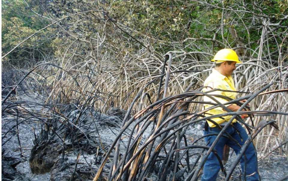
Foto 5. Construyendo ruta de acceso en superficie quemada.
