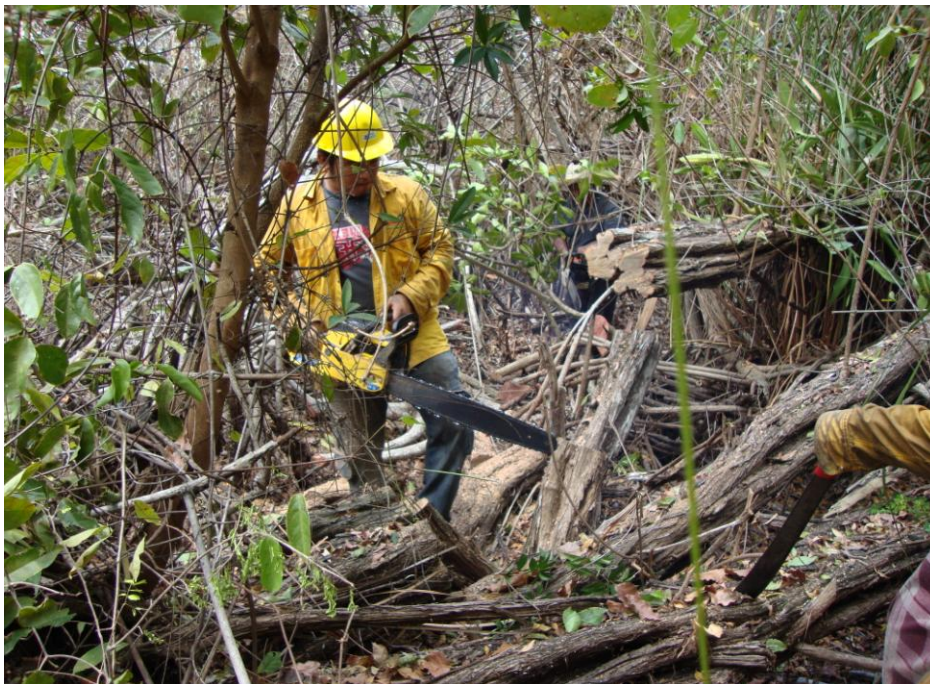
Foto 1. Construcción de la ruta de acceso y escape
