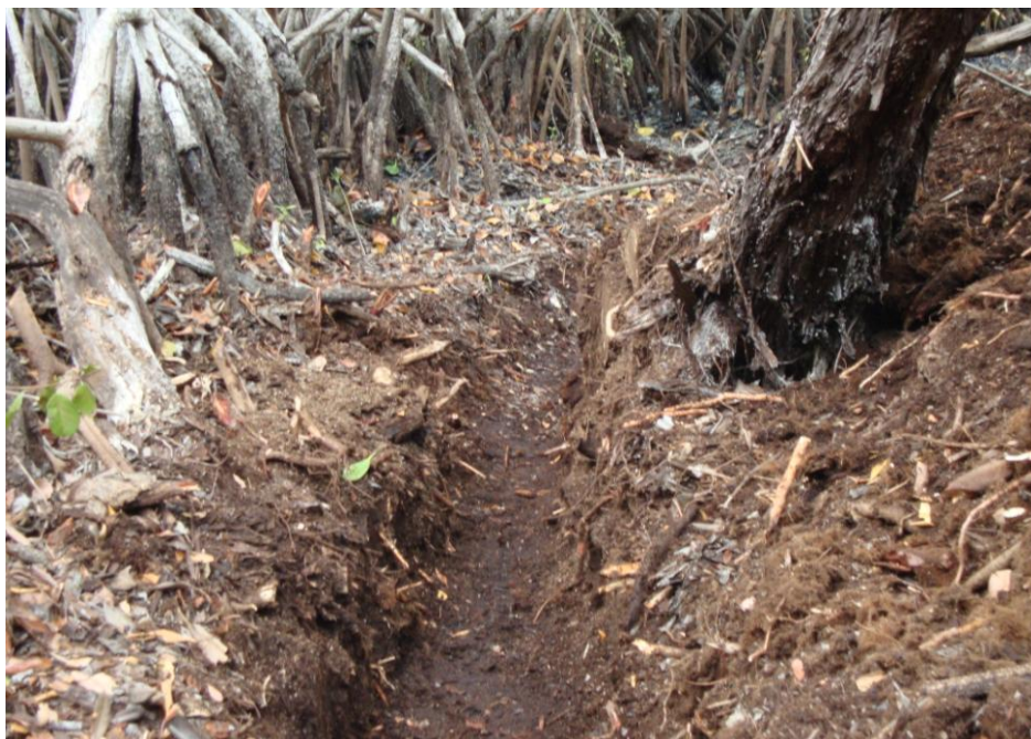
Foto 18. Zanja terminada para evitar incendios subterráneos.
