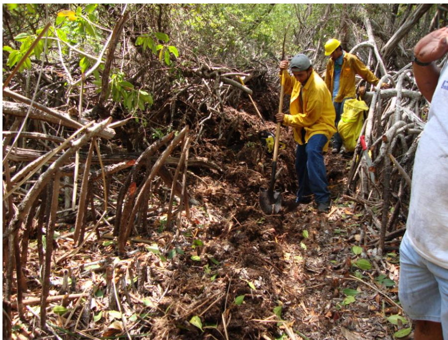
Foto 15. Construcción de la zanja de suelos profundos.
