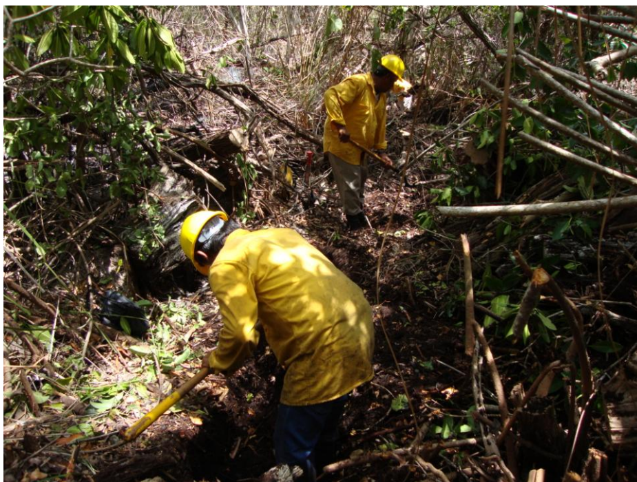
Foto 16. Brigadistas realizando la construcción de la zanja.
