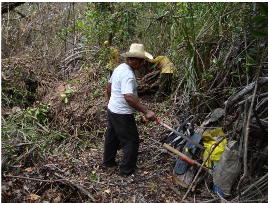
Foto 20. Brigada del proyecto realizando la construcción de la brecha en terrenos altos.
