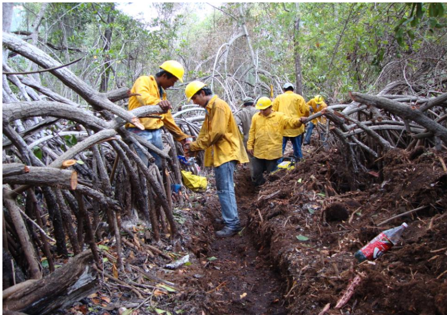
Foto 17. Zanja a punto de concluirse.
