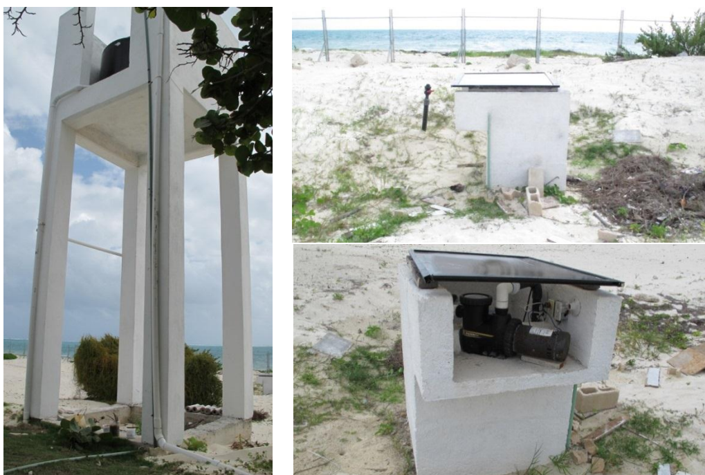
FIGURA 78. Modificaciones a la línea de abastecimiento de agua marina existente. Instalación de un tinaco elevado (izq) y de una bomba en reservorio de agua marina enterrado (der).
