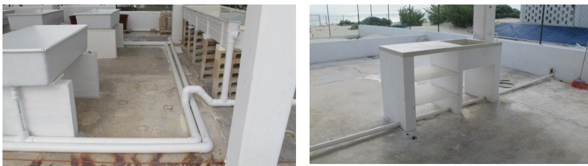
FIGURA 76. Instalación hidráulica de abastecimiento y desagüe para tinas de cultivo del SCE (izq.) y Lavabo con suministro de agua dulce (der.).
