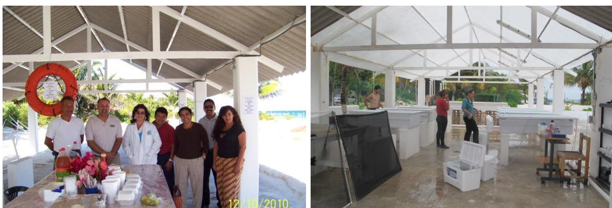
FIGURA 20. Adecuación de instalaciones en el CRIP Puerto Morelos del INAPESCA para el establecimiento del Sistema de cultivo de corales exterior (SCE). Antes de iniciar el proyecto (izq.) y al terminar la 1ª etapa (der.).
