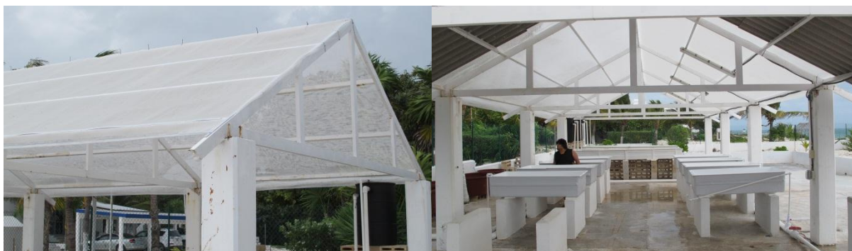
FIGURA 73. Techo de malla sombra para cubrir el área de los SCE.
