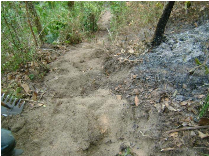
Construcción de zanjas
