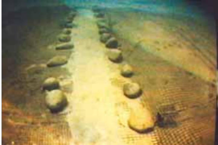
Figura 13.- Vista del segundo diseño elaborado para la estructura de protección, donde se observa el doblez de la misma malla a lo largo de todo el perímetro anclada con rocas.
