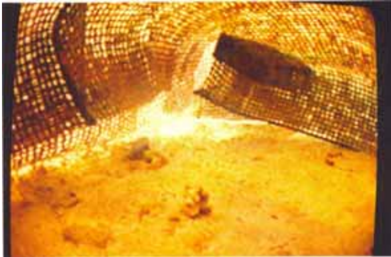
Figura 12: Vista interior de la estructura de protección (primer diseño) donde se observa la pared de la malla ligeramente levantada del fondo.
