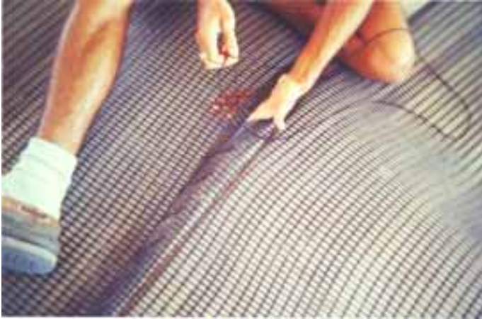
3.- Los rollos se unen entre si con piola alquitranada.
