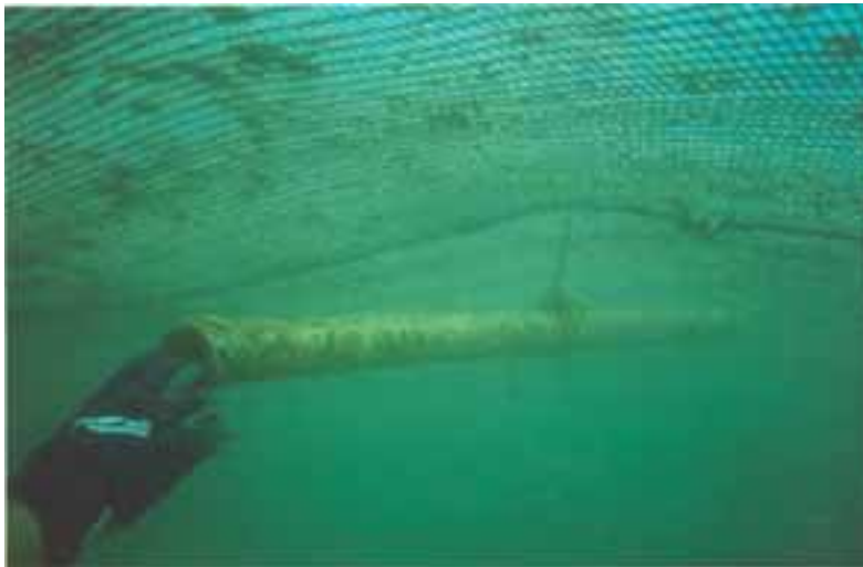
Figura 6a.- Vista del tubo de PVC instalado en el interior de cada una de las estructuras de protección.
