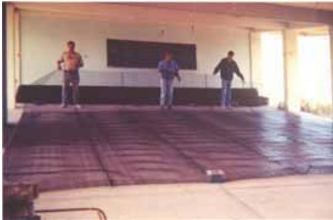
4.- Las estructuras terminadas se enrollan para trasladarse a los sitios en que serán instaladas.
