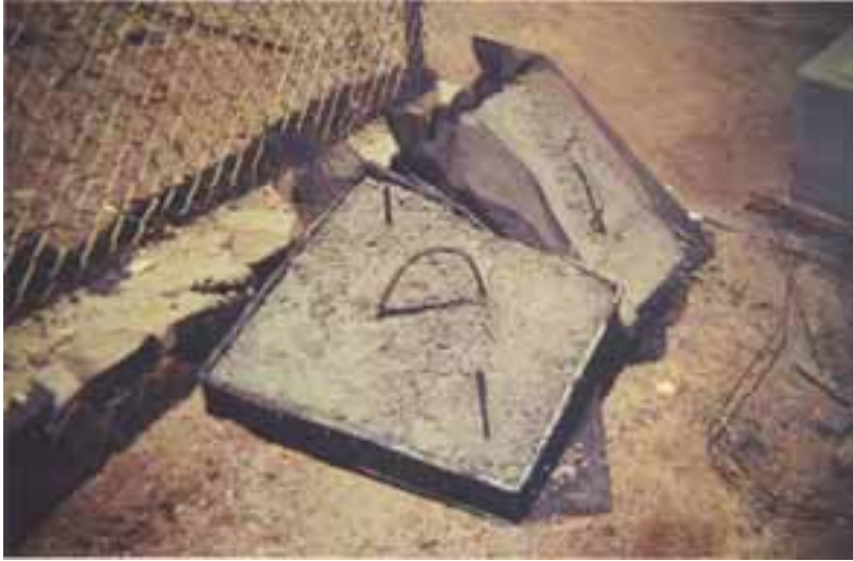
Figura 8.- Bloques de concreto ("muertos") utilizados para el anclaje de las estructuras de protección.
