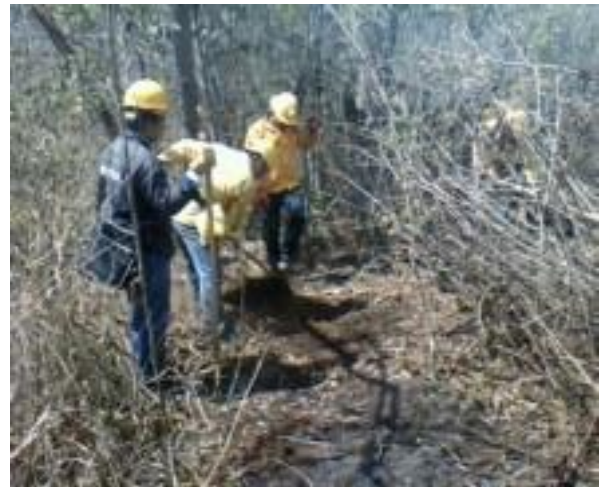
Construcción de líneas de fuego en selva baja caducifolia.
