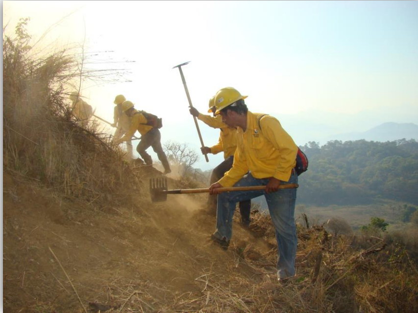
Foto_APRN_03. Construcción de brechas cortafuego
