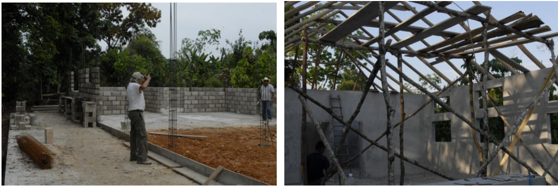
Figura 3. Supervisión en diferentes fases de la construcción del taller artesanal.
