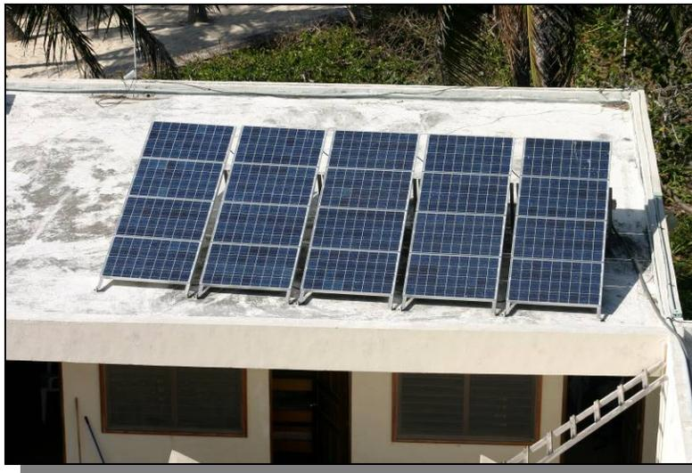
Foto 3.7 En la que se aprecian algunas de las fotoceldas con las que cuenta el centro de visitantes, colocadas arriba de los dormitorios de la planta alta de la estación. (González T. A. 2005)
