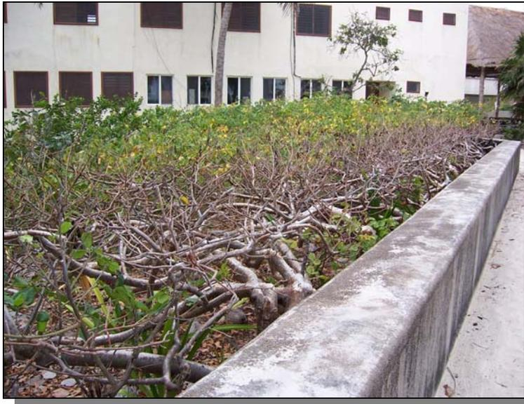
Foto 3.8 Humedal artificial del que se vale la estación para resolver en parte el tema de aguas residuales, al fondo el área de dormitorios y la palapa comedor junto al museo. (Alcérreca A.C. 2005)
