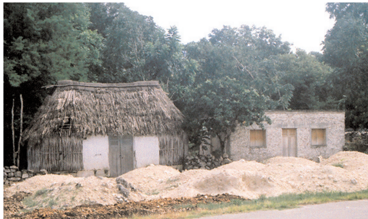
La casa tradicional maya esta construída con los materiales de la región que incluyen en su estructura diferentes especies de árboles y bejucos, incluyendo la palma conocida como huano, que se usa para la construcción del techo, lo que la hace muy fresca y agradable.
