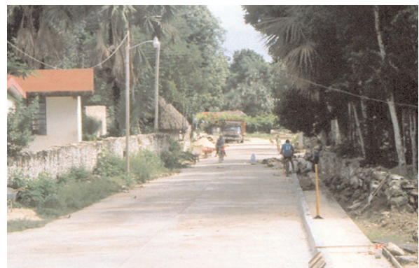
Algunas de las calles en Xmaben se pavimentaron en 2003 y actualmente se están construyendo las banquetas en el pueblo.
