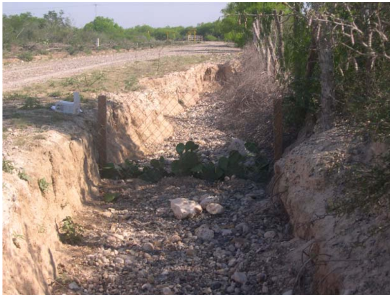
Figura 2.7. Efecto de la construcción de caminos de acceso en la formación de cárcavas, en el rancho Santa Clara del Orégano
