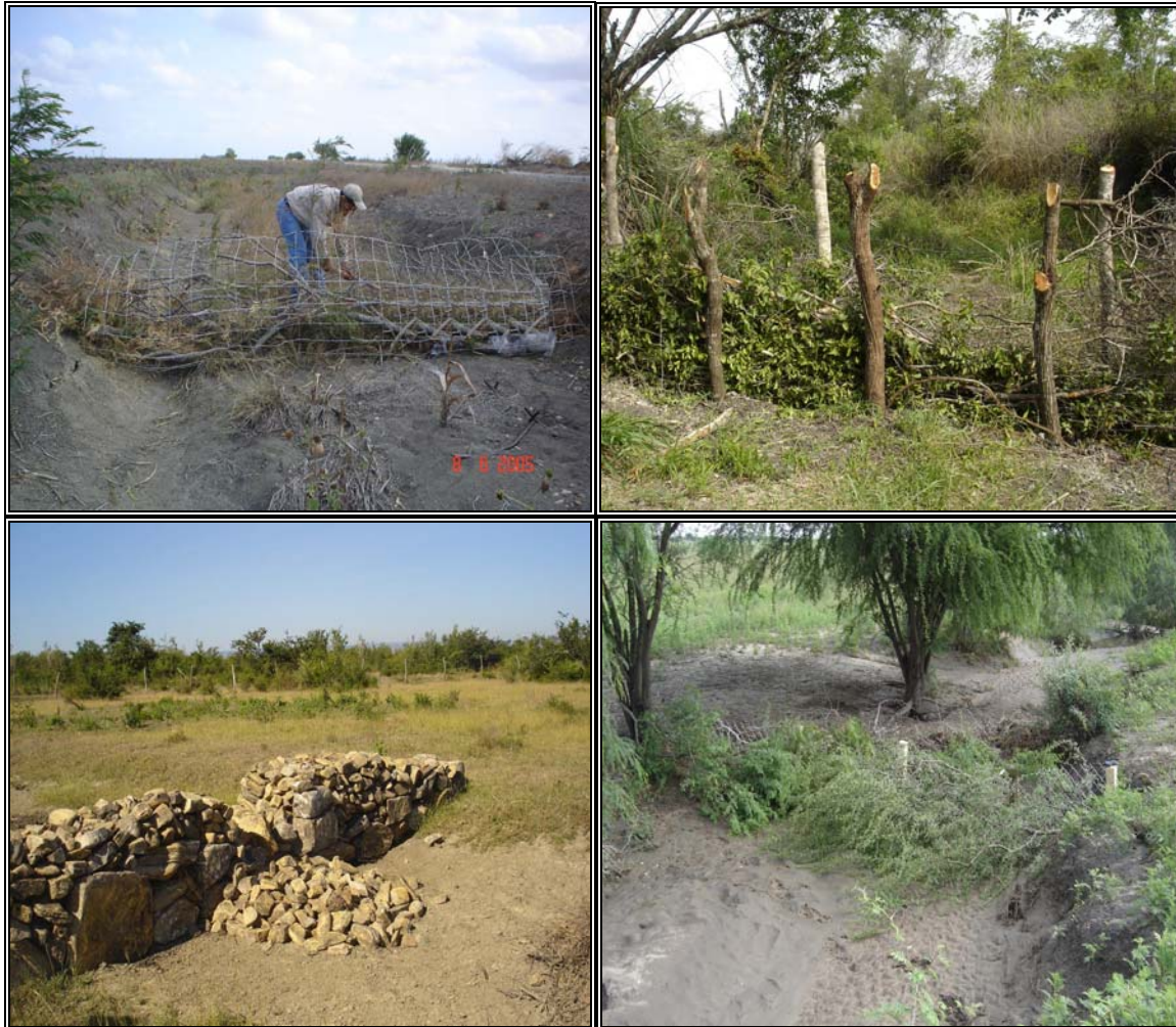
Figura 4. Represas construidas, con distintos materiales: ramas con tela, postes con ramas piedra, y madera con malla.
