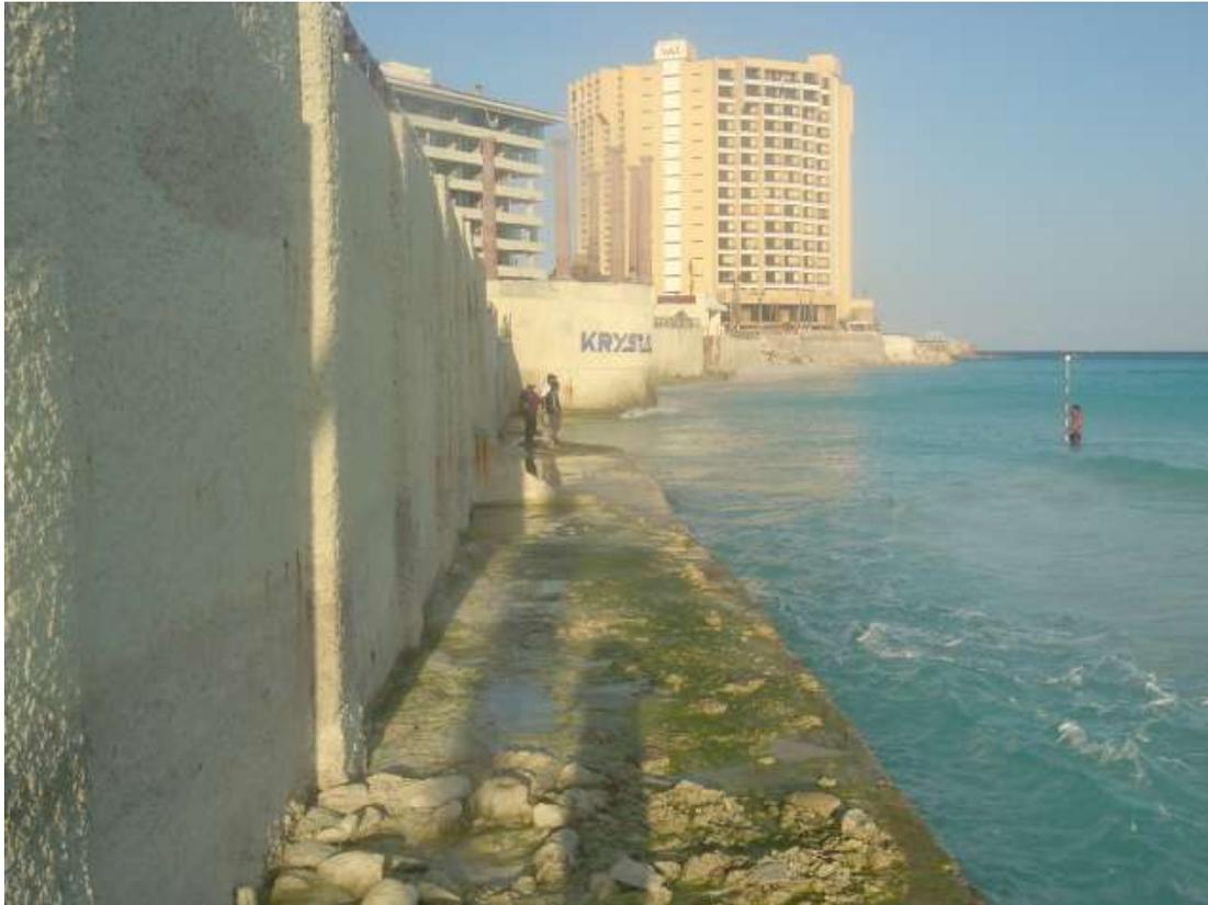
Foto 7 Playa externa completamente erosionada por la acción del oleaje generado por el huracán Wilma.
